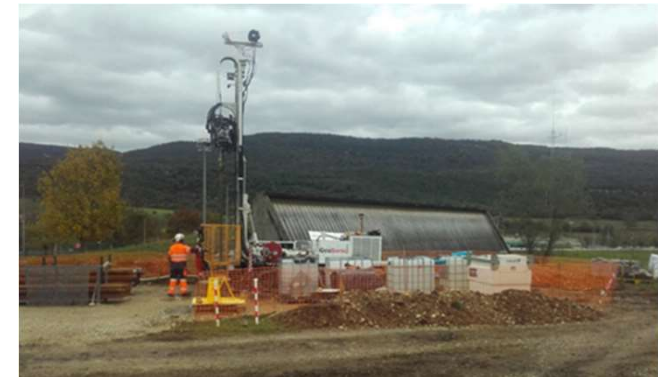
Dans le cadre du réexamen de sûreté de l'APEC, (déposé par EDF en 2015 et en cours d'instruction), l'IRSN a demandé un complément d'étude sismique et un engagement d'EDF pour réaliser plusieurs actions, dont un forage sur le site de Creys-Malville.
