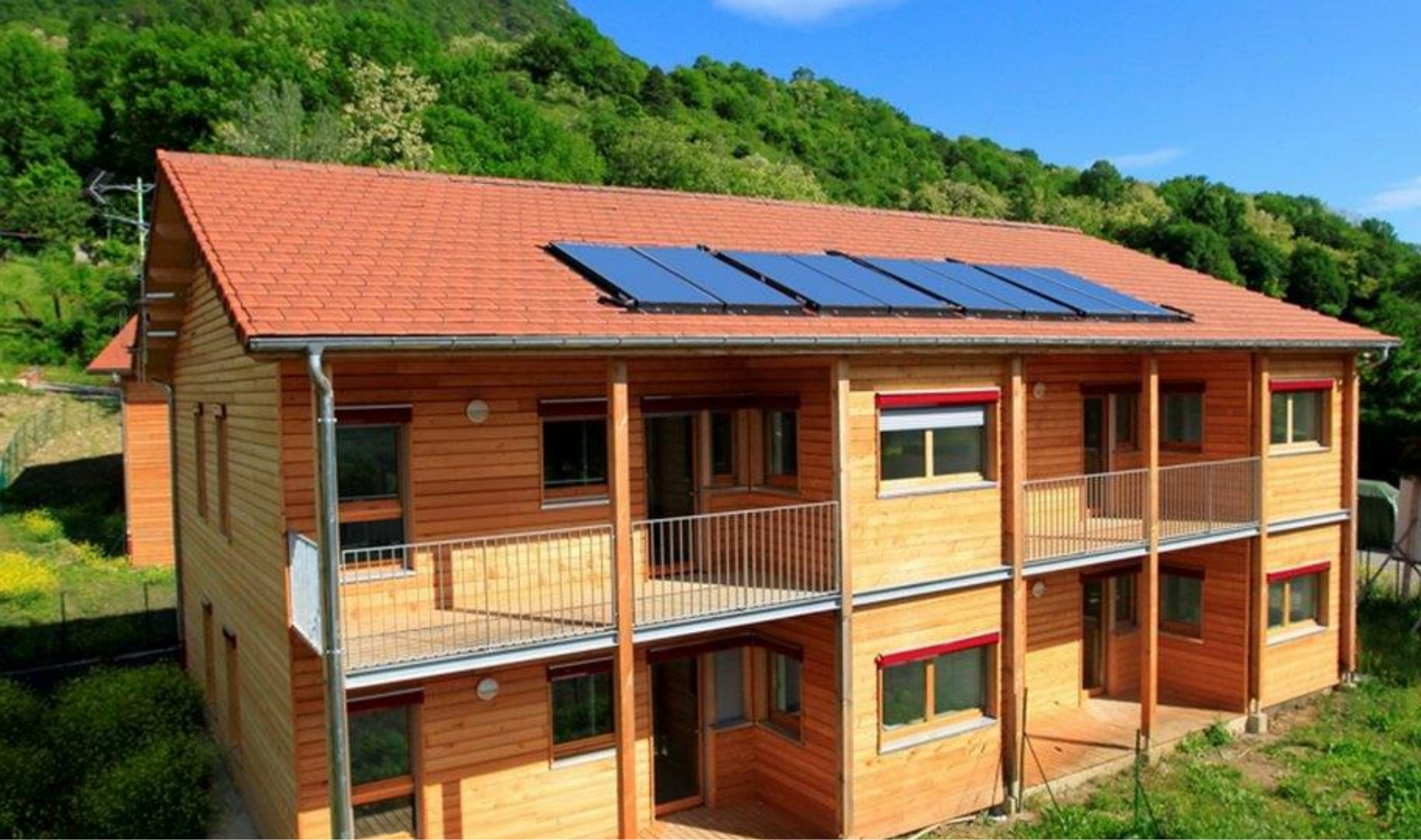
2009 : Logements locatifs «La petite chartreuse » La Terrasse
