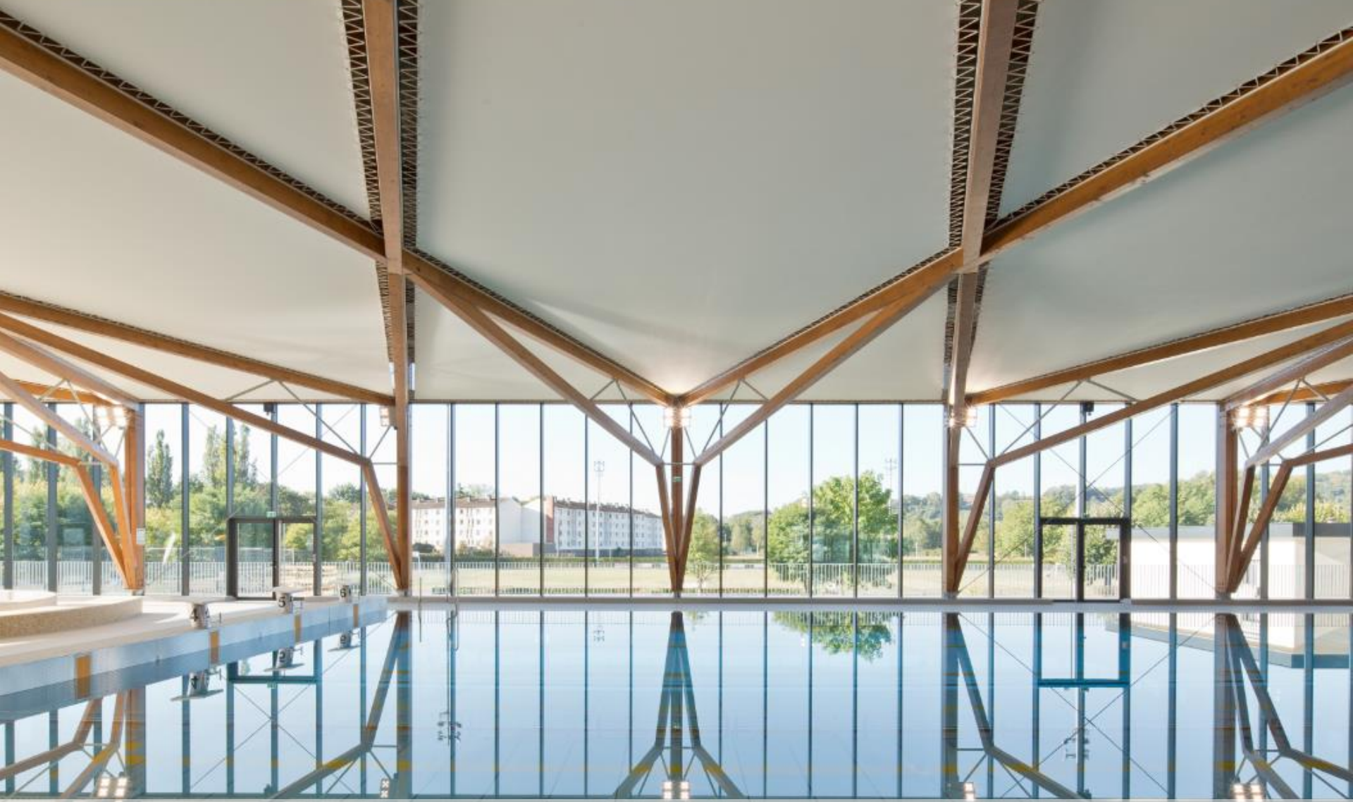
2020 (6) : Piscine des Balcons du Dauphiné Morestel
