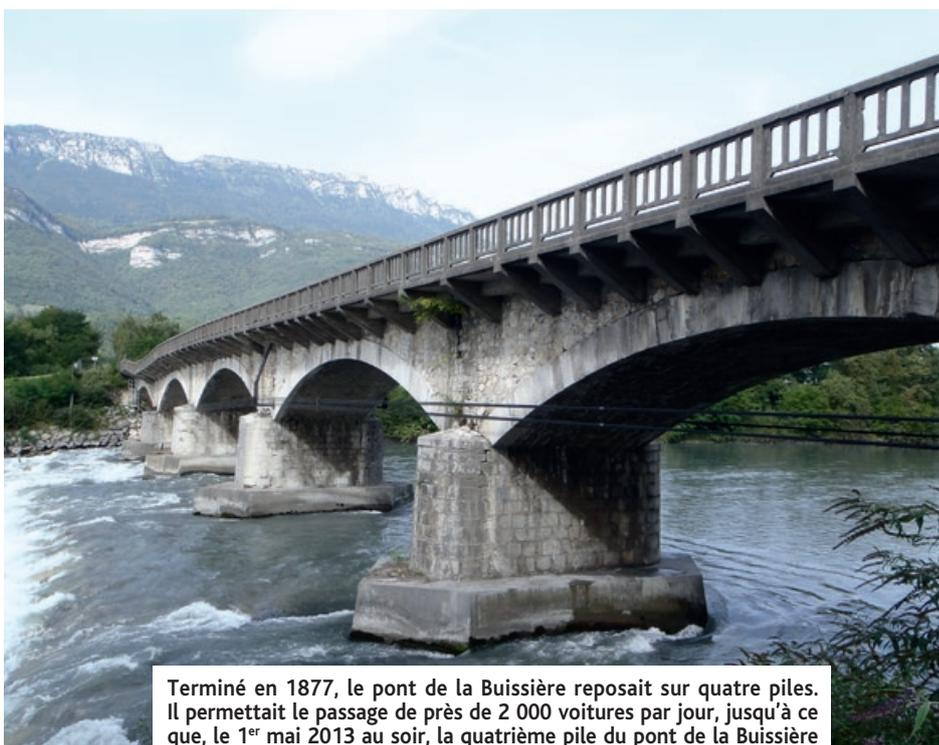
Terminé en 1877, le pont de la Buissière reposait sur quatre piles. Il permettait le passage de près de 2 000 voitures par jour, jusqu'à ce que, le 1<sup>er</sup> mai 2013 au soir, la quatrième pile du pont de la Buissière s'enfonça de 75 cm.
