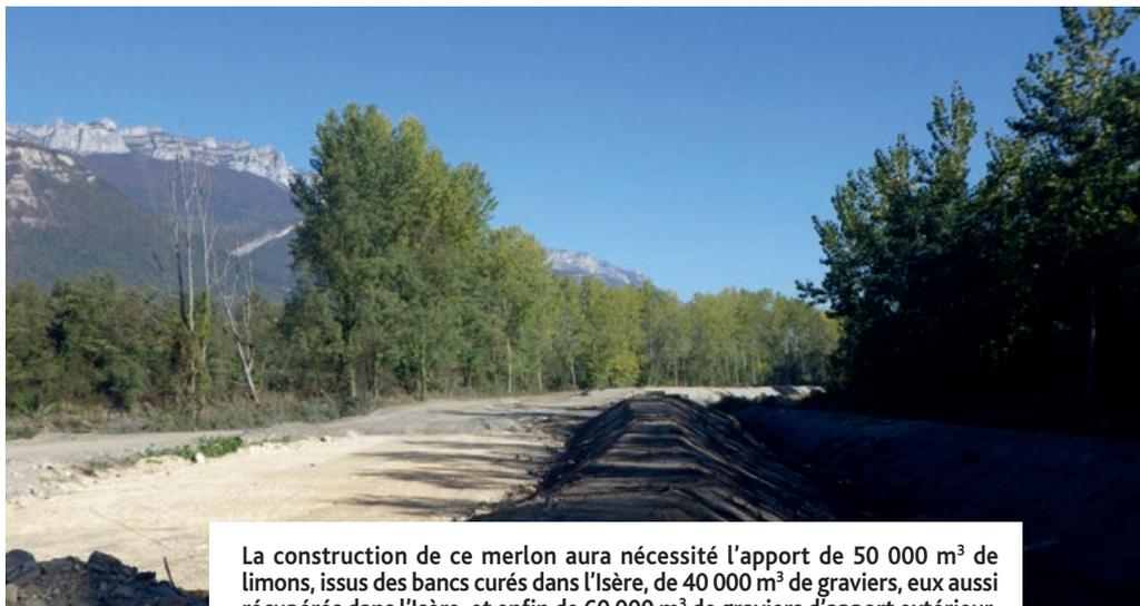
La construction de ce merlon aura nécessité l'apport de 50 000 m<sup>3</sup> de limons, issus des bancs curés dans l'Isère, de 40 000 m<sup>3</sup> de graviers, eux aussi récupérés dans l'Isère, et enfin de 60 000 m<sup>3</sup> de graviers d'apport extérieur.
