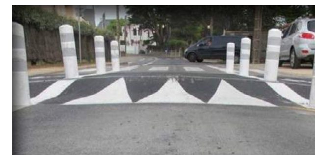
Ralentisseur trop marqué avec des traces de raclements
