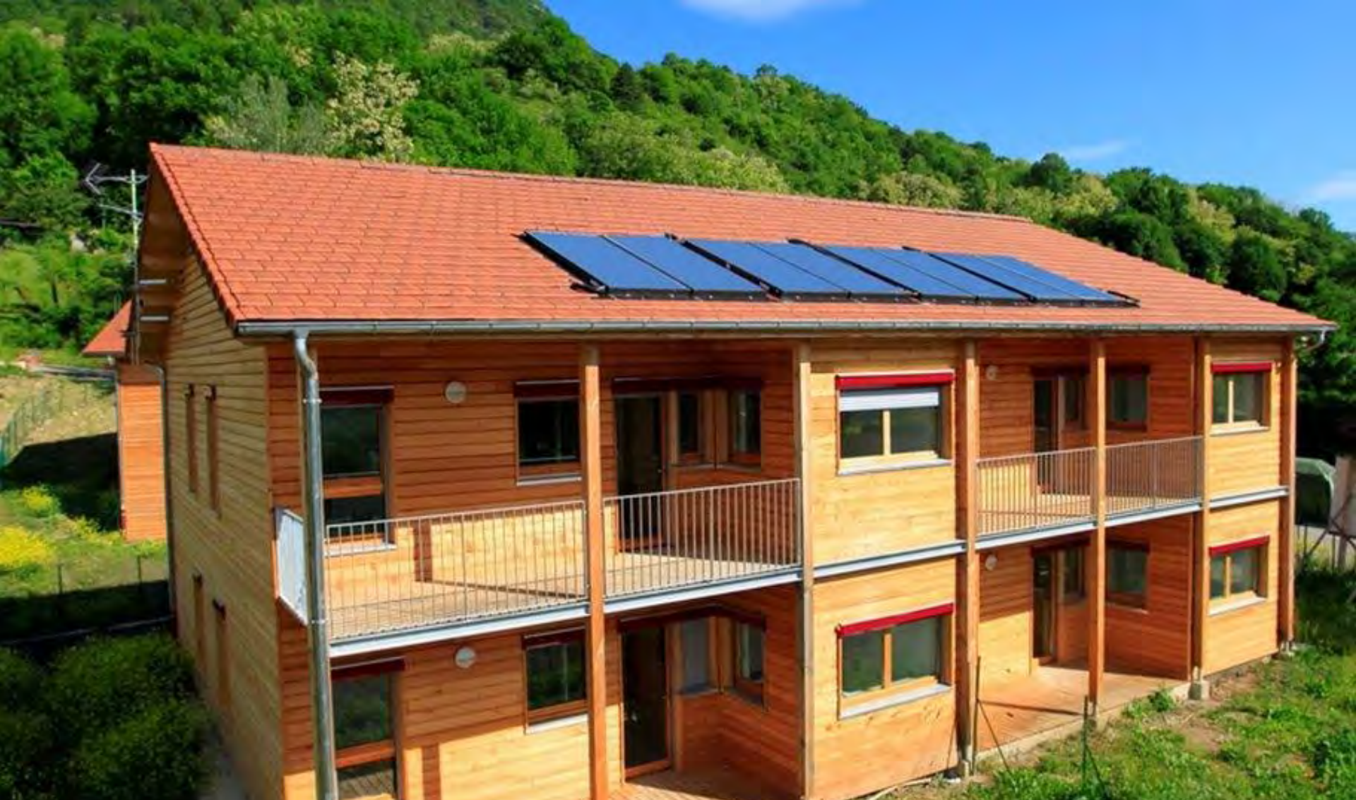
2009 : Logements locatifs «La petite chartreuse » La Terrasse
