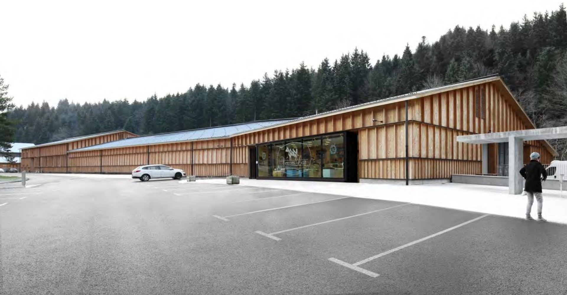
2019 (2) : Rénovation et agrandissement de la Coopérative Vercors Lait Villard de Lans
