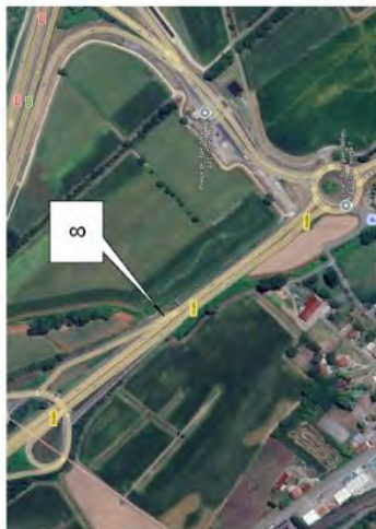
Repère 8 - Bretelle de sortie D1006_E08 au PR14+340 (D1006)
