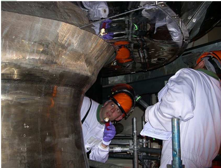
Contrôle de la soudure de raccordement du circuit primaire à la volute d'une pompe primaire
